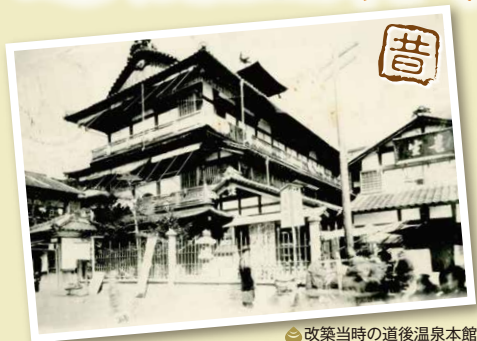
改築当時の道後温泉本館
