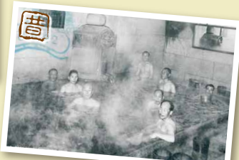
養生湯の様子
